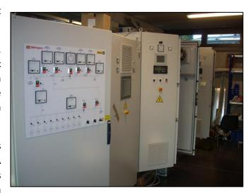
conception, construction et programmation des armoires de commande groupes et pour l'automatisation des armoires commande des groupes électrogènes de secours 250 et 500kVA.
